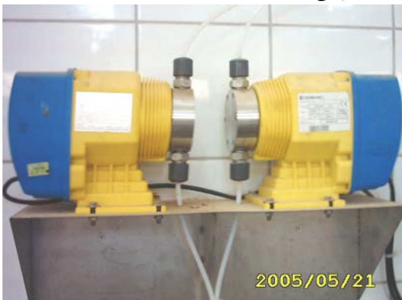
شكل ١٤ المضخات المستخدمة للتحكم في تراكيز الحامض والقلوي
