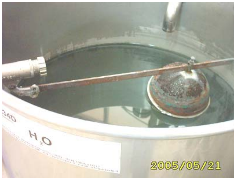
شكل ٢,٤ التحكم في مستوى الماء في صهرج الماء باستخدام عوامة
