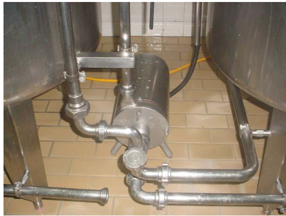
شكل (٦٥) صمامات لسحب عينات للتحليل الدوري
