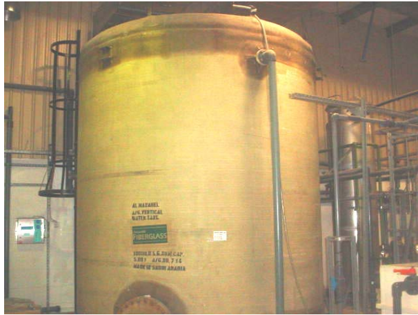
شكل (٤٥) الخزانات الأرضية
