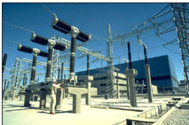
شكل (١، ٣٣ ب) العوازل الكهربائية أثناء تركيبها.
