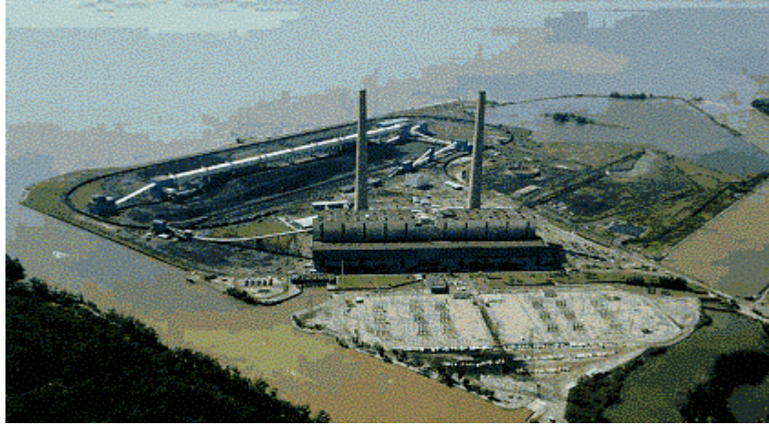
شكل (٨،٤) محطة توليد كهربائية.
