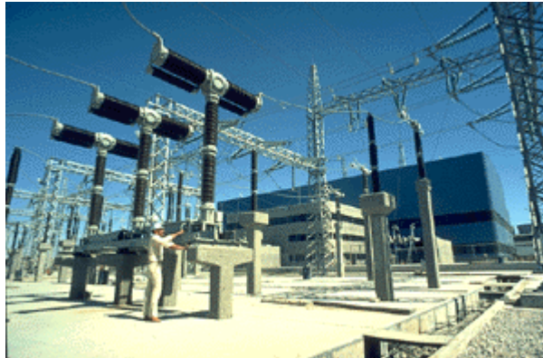
شكل (١٢,٤) خطوط النقل ومحولات خفض الجهد.
